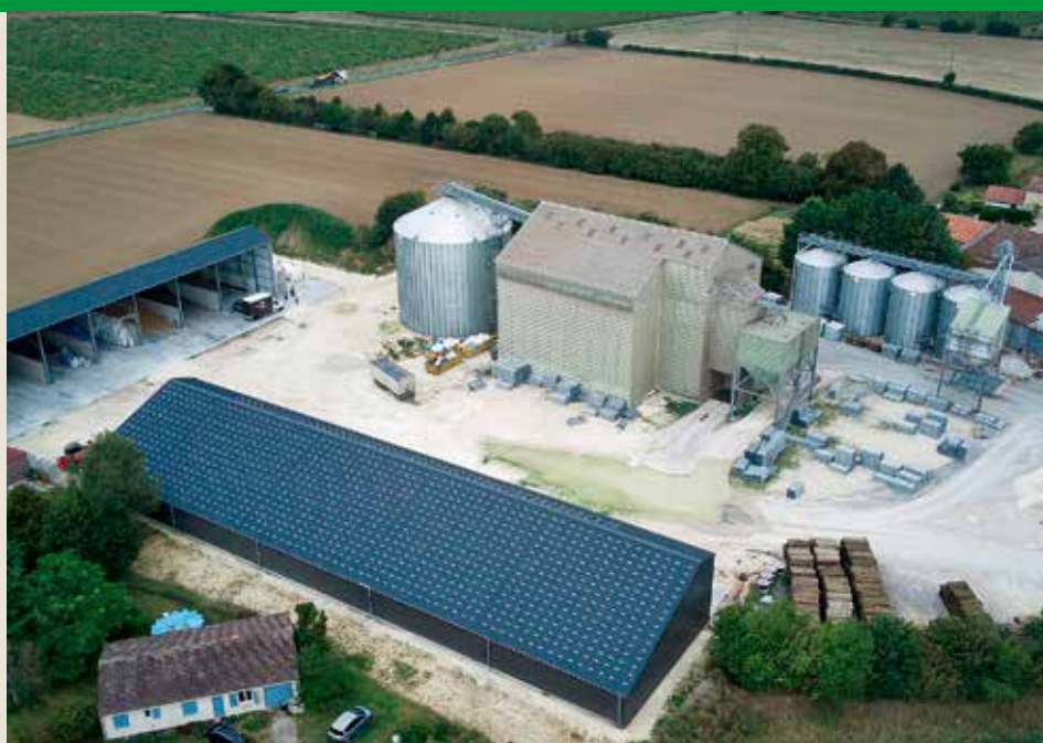
Le site rouillacais de la CARC et ses panneaux photovoltaïques vus du ciel.
